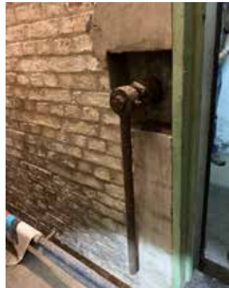
Gasdichte pantserdeuren verdwenen maar hier en daar bleef het sluitwerk behouden
