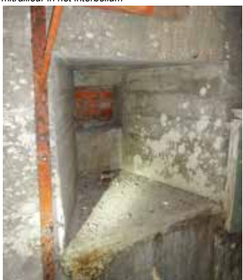
Interieur flankeringsbunker met opstelling lichte mitrailleur
