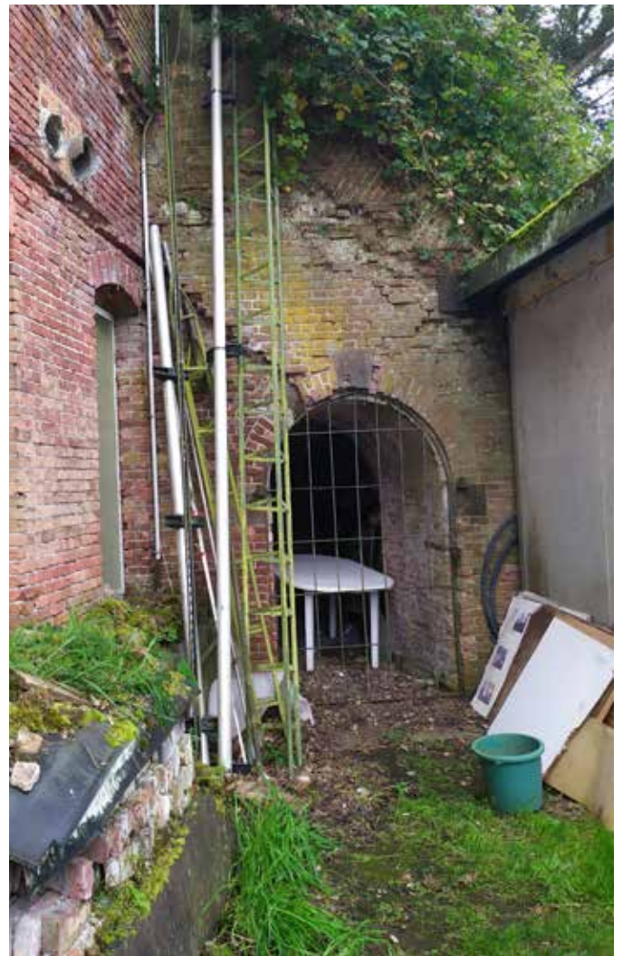
tunnel (verbindingsgang) rechtercaponnière
