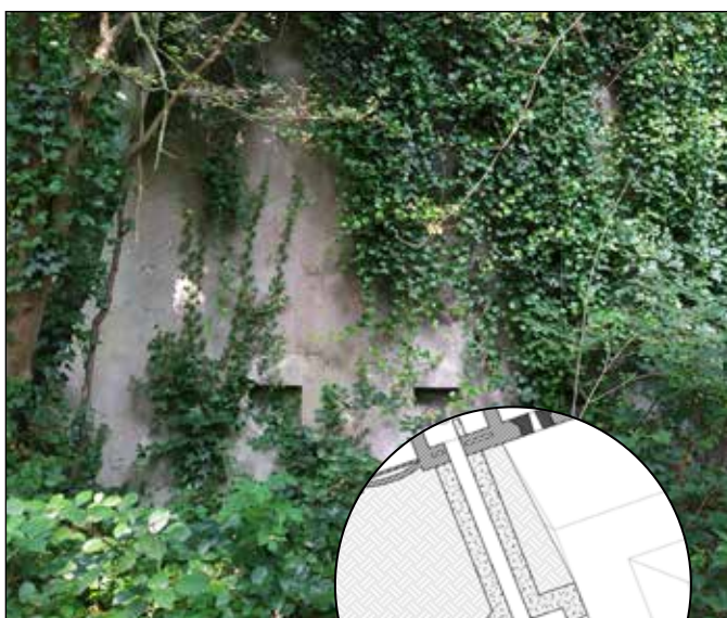
Flankeringsbatterij is overwoekerd door begroeiing.
