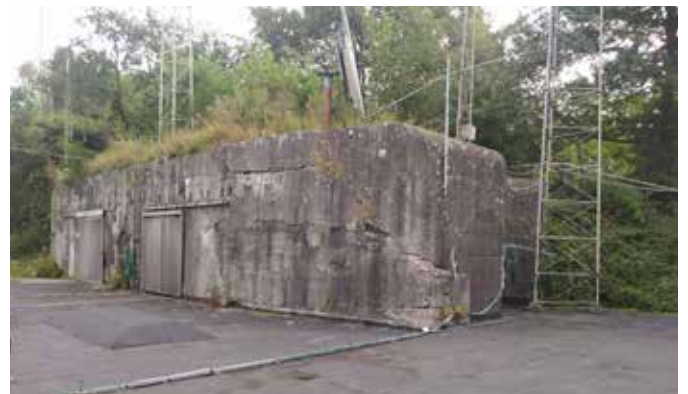
Interbellumbunker boven op het hoofdfrontgebouw
