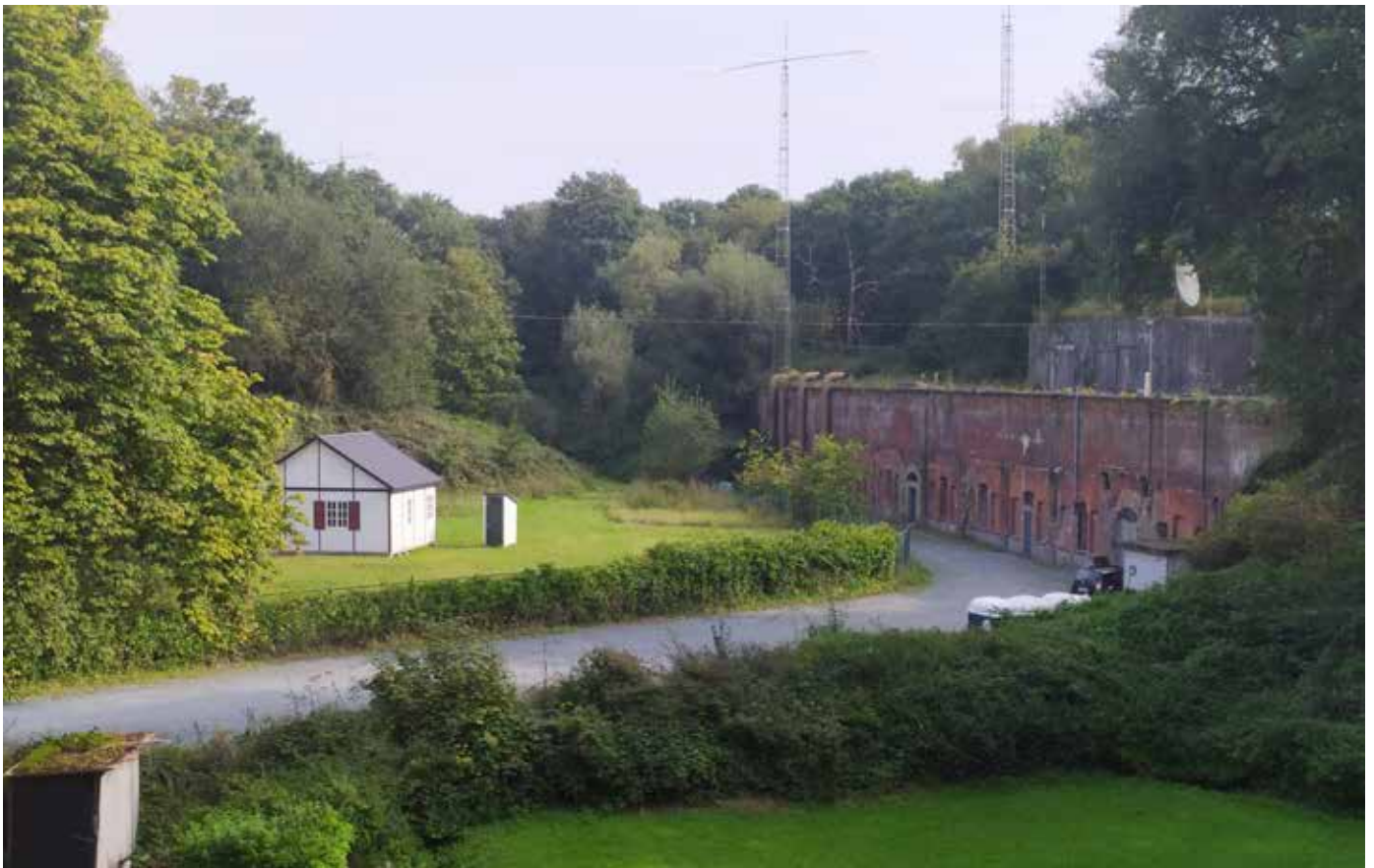
terreplein tussen hoofdfrontgebouw en kazerne
