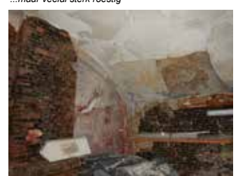
Officierengebouw: geschilderde fries achter uniforme verlaag
