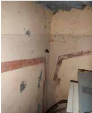
Interbellum bunkers bovenop hoofdfrontgebouw: oorspronkelijke Art-Deco wandschildering
