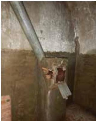
Elementen van de oorspronkelijke overdrukinstallatie (buiten houden strijdassen)
