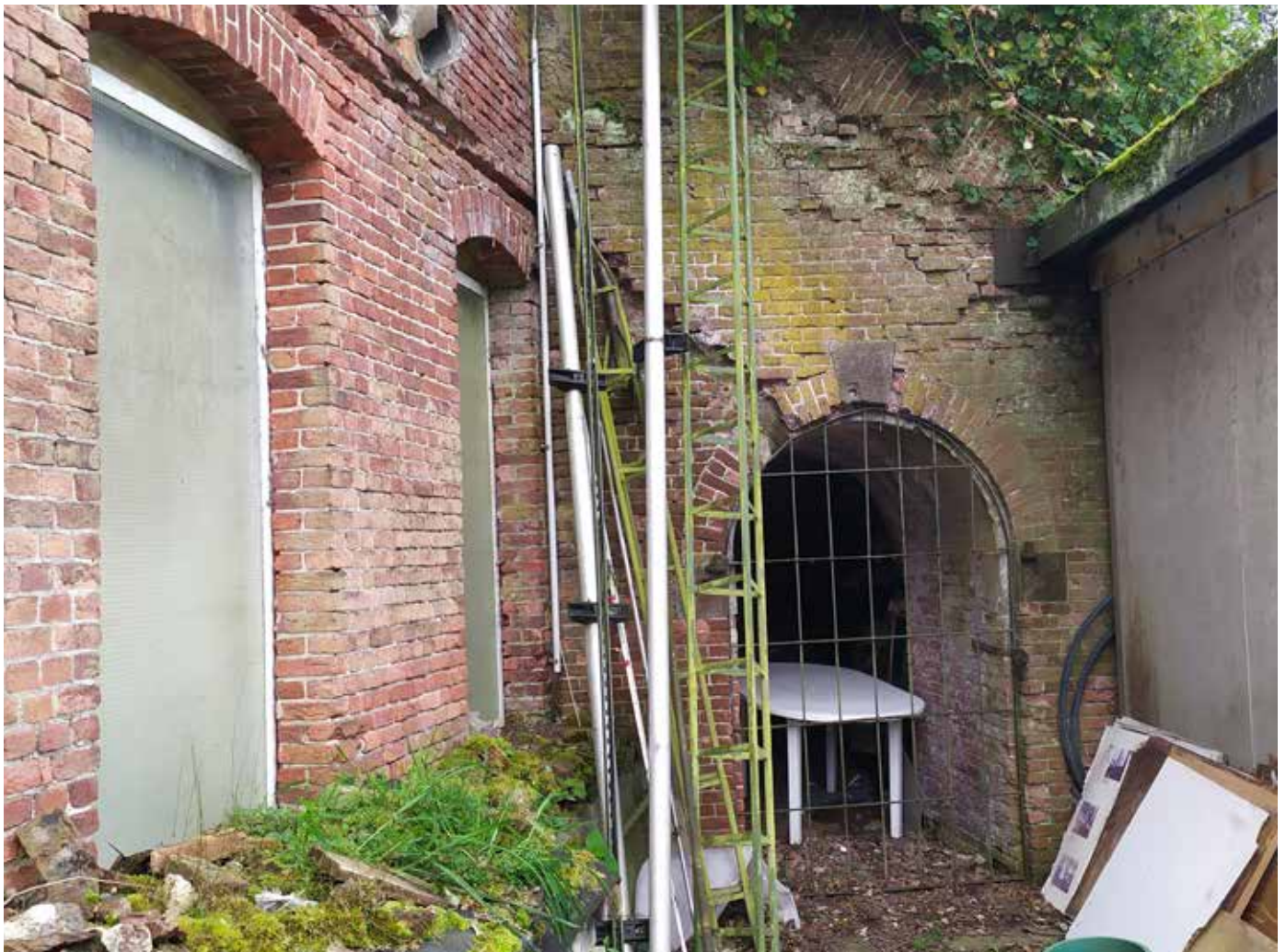
Rechte verbindingsgang die het hoofdfrontgebouw met de rechtse halve caponnière verbindt.
