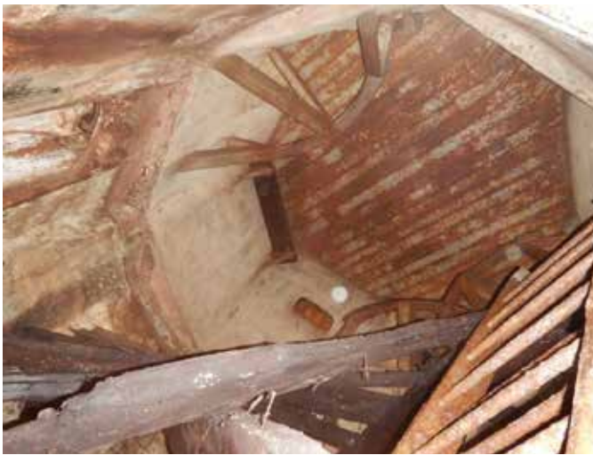
metalen onderdelen abris tourelle en kazematten (monumentenw.)
