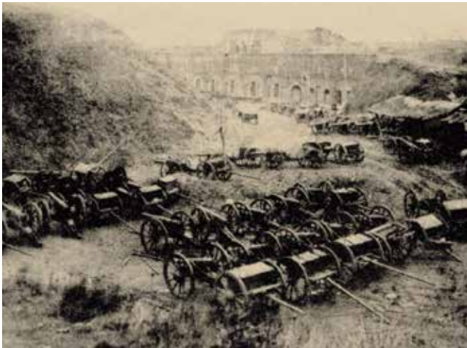
terreplein voor opstelling geschut - merk traverse op, momenteel afgegraven en open ruimte, bron: Archief Lier (beeldbank)
