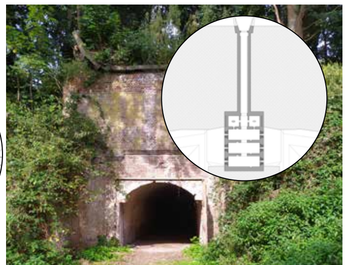
Toegang van de keelcaponnière
