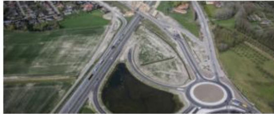
BRUGGE A11 - AANLEG AUTOSNELWEG TSS BRUGGE EN KNOKKE (2014.I.004)
